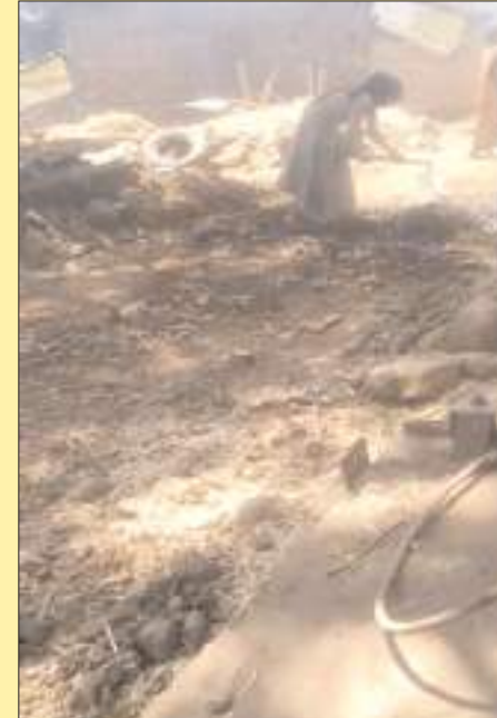
सड़क के आस-पास की गिट्टी सड़क के बेस में बिछाते नजदूर
